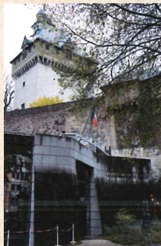
Bâtiment Paulette BESSON à la préfecture de la Savoie
