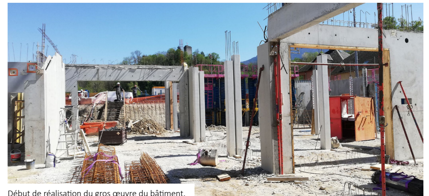
Début de réalisation du gros œuvre du bâtiment.
