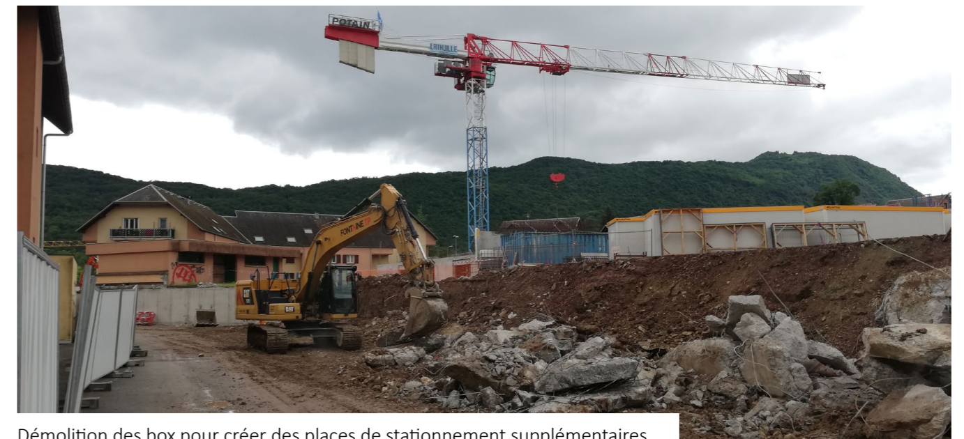
Démolition des box pour créer des places de stationnement supplémentaires.
