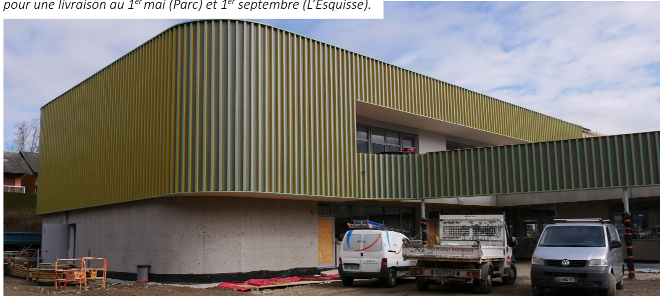
Pose du carrelage, réalisation des faux-plafonds, les entreprises se succèdent pour les travaux d'aménagement intérieur.
