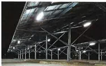
Des luminaires sont installés sous les ombrières dans le but d'améliorer la visibilité et la sécurité des usagers. Cet éclairage sera câblé sur la boucle d'éclairage existante ou sur un autre réseau pour l'école pour en faciliter l'usage.
