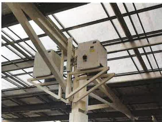
Les onduleurs permettent la conversion du courant continu en courant alternatif, propre à l'injection sur le réseau.
